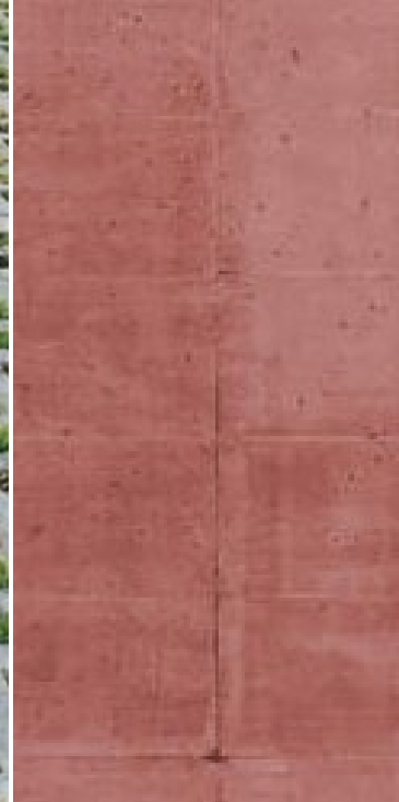
Roter Beton für Sitzbühne
