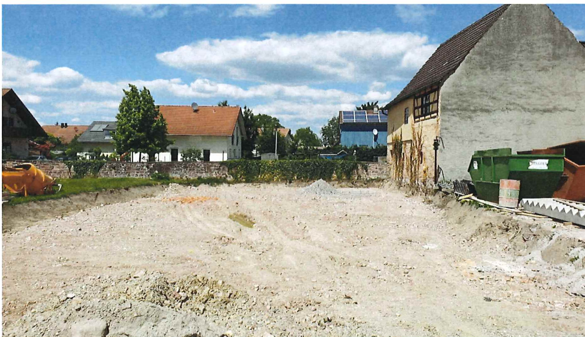
Abb.: Plangebiet im Mai 2020, Blick Richtung Norden
